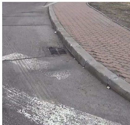
Fot. 5. Wpust deszczowy.
